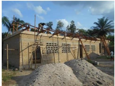
Les murs ont été construits en briques dites «écologiques» (Adobe), d'une hauteur de 3,20 m et d'une épaisseur de 22 cm. Ces briques sont non cuites, fabriquées à partir d'un mélange d'argile, de sable et de ciment. Ils sont dits écologiques car ils ne nécessitent pas de bois de chauffage pour leur fabrication et conservent ainsi la
